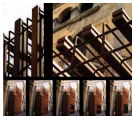
Vivienda entre medianeras. Acero corrugado y tablonos de pino Proyecto: Toni Gironés Contacto: www.tonigirones.com
